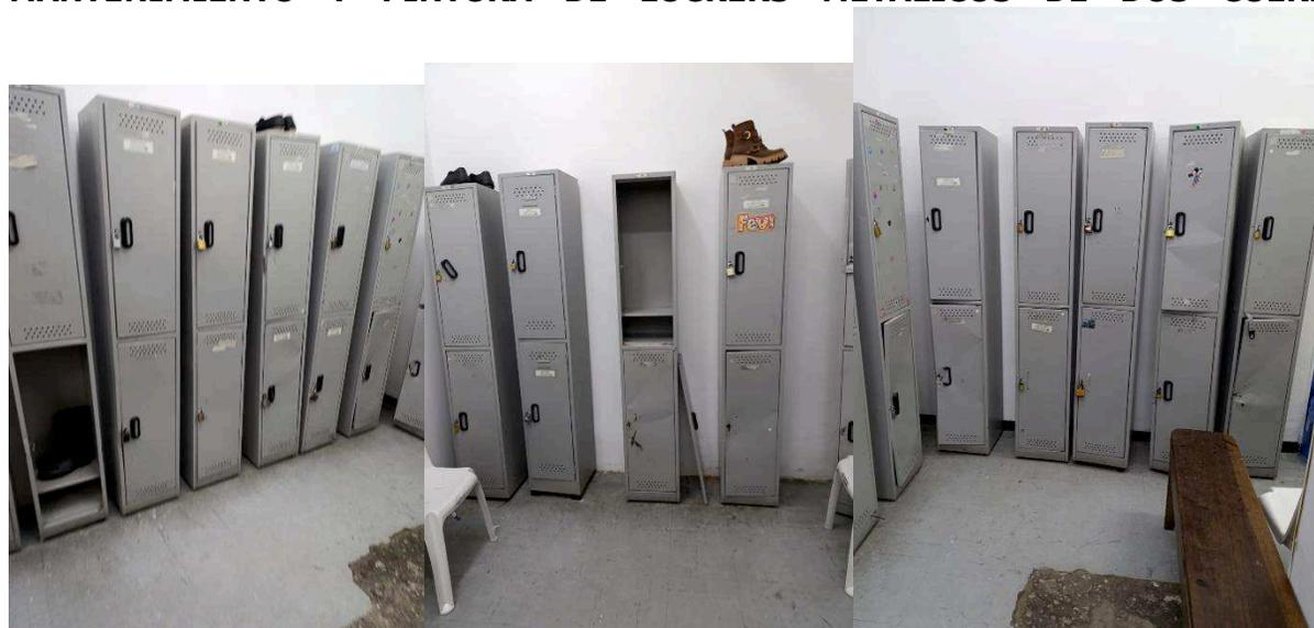
Mantenimiento y pintura de lockers organizador metálicos de dos cuerpos elaborados en lámina cold rolled, se recomienda inspeccionar los lockers para detectar signos de corrosión o daño, procediendo a su reparación y repintado para prolongar su vida útil de cada locker organizador.
