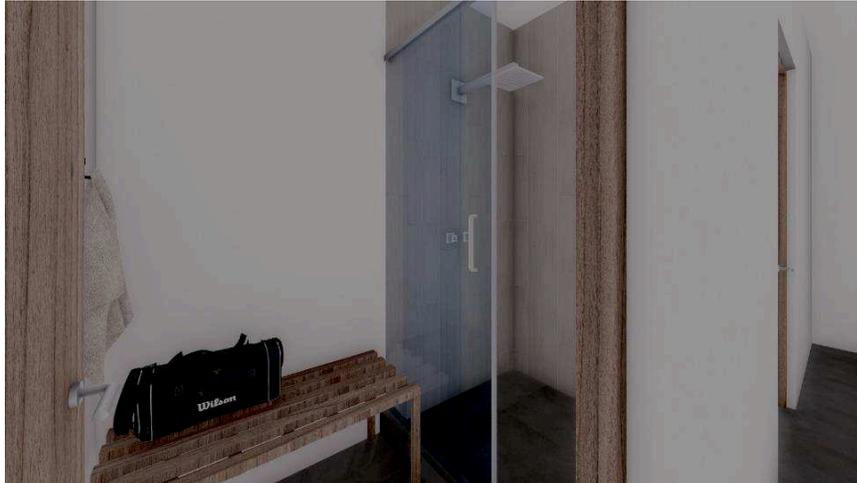
Suministro e instalación de división en vidrio templado de e 8 mm una puerta corrediza o batiente, vidrio fijo y lateral en vidrio templado laminado, esmerilado, kit de instalación con accesorios en acero inoxidable y riel para la puerta, los vidrios deben tener un espesor 8 mm, medidas de división y puerta son (1.90 m de alto x 1.20 m de ancho).
