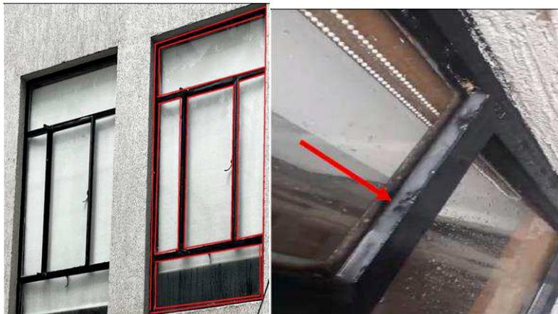
Suministro e instalación de sellado de ventanería con adhesivo y sellador de juntas elástico, monocomponente tipo silicona o masilla negra tipo breca en el perímetro de las ventanas (según material instalado actualmente), con el fin de evitar el ingreso de aguas lluvias y humedad exterior por las rendijas que se forman entre los marcos y los muros de la edificación.
