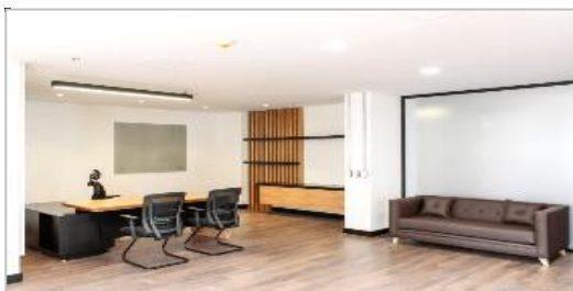
Figura 10. Cielos Raso y Muros en Drywall
