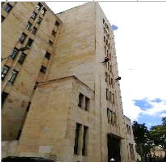
Figura 13. Lavado, cambio y sellado de piezas
