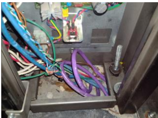
Instalación de cable F/UTP
