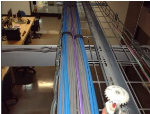
Instalación de cable F/UTP
