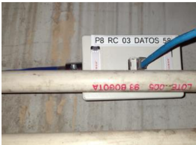
Terminación de punto [sector I]
