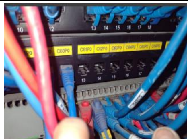
Instalación y marquillado de patch cords
