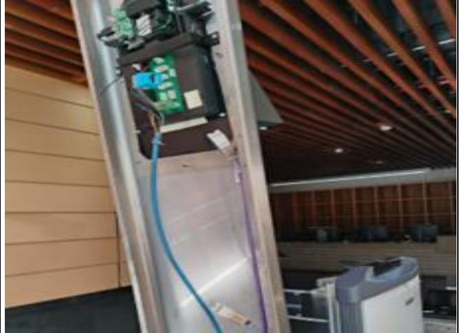
Instalación de cable F/UTP
