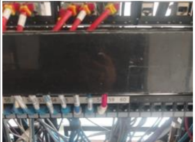
Instalación y marquillado de patch cord
