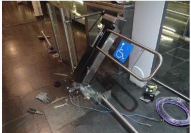
Instalación de cable F/UTP
