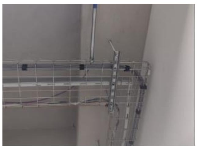
Instalación de tubo EMT y cable F/UTP
