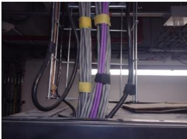
Instalación de cable F/UTP
