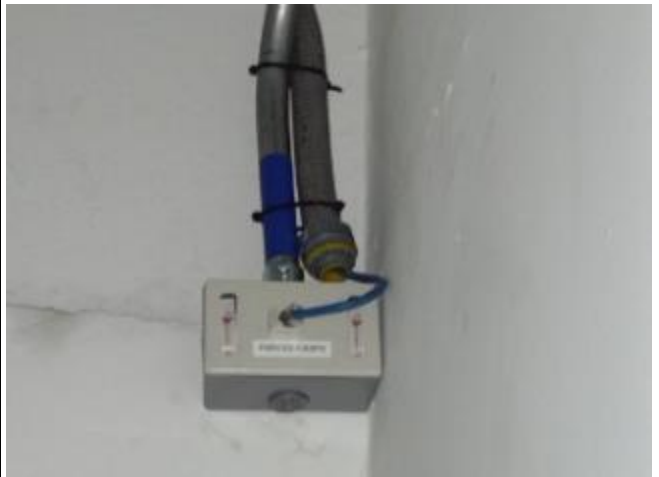
Terminación de punto [Sector C]
