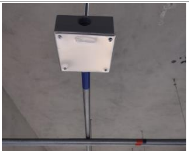
Instalación de tubo EMT y caja
