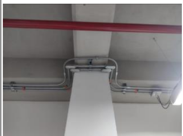
Instalación de tubo EMT
