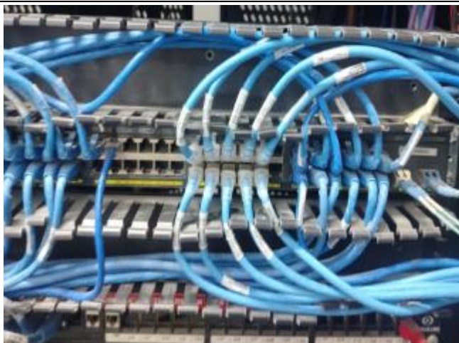
Instalación y marquillado de patch cord
