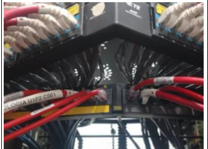
Instalación, ponchado y marquillado en patch panel
