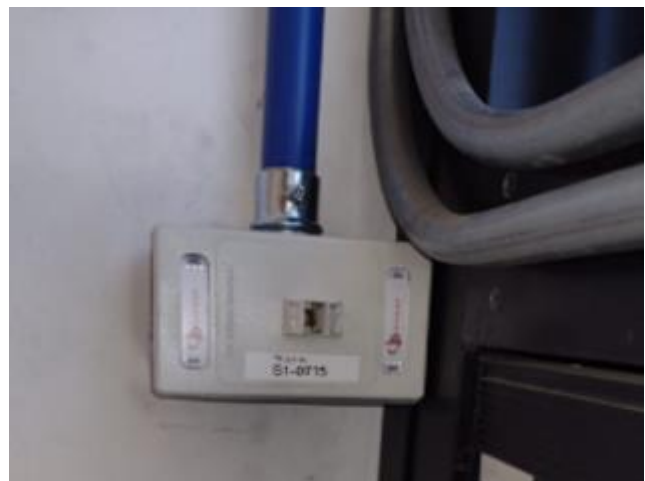
Terminación de punto [Sector M]
