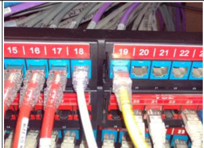
Instalación y marquillado de patch cord
