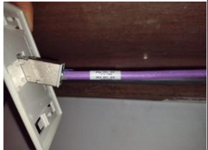
Ponchado y marquillado [Sector B]
