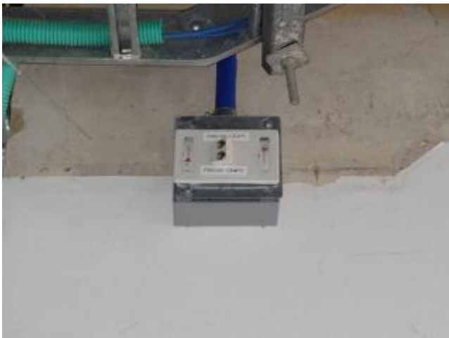
Terminación de puntos [sector A]
