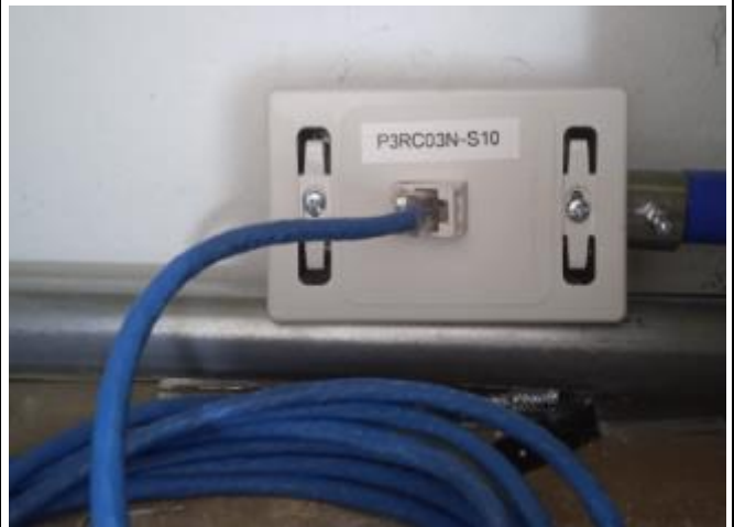
Terminación de punto [Sector D]
