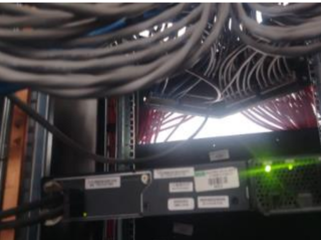
Instalación, ponchado y marquillado en patch panel
