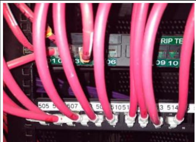
Instalación de cable F/UTP y ponchado en patch panel
